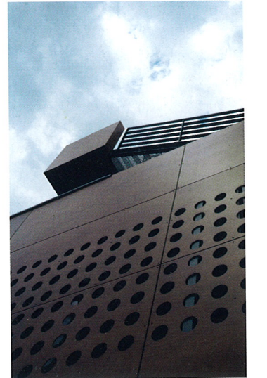
Peau de bois Derrière le mur de soubassement en pierre se glisse le garage. Posée par-dessus, la boîte en structure métallique et sa peau de bois perforée accueillent les trois étages de la maison. À son sommet trône la terrasse abritée avec vue à 360° sur la ville.
